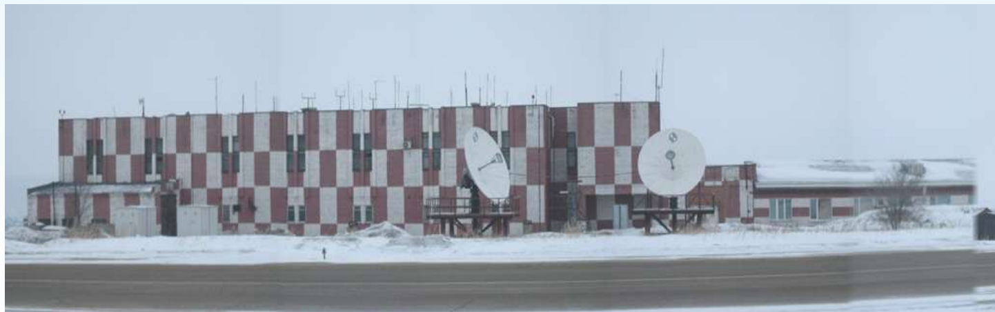
Здание укрупненного центра ЕС ОрВД до реконструкции
